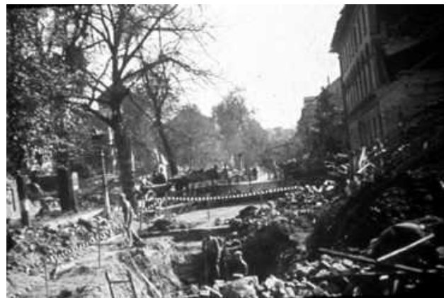
Kanalarbeiten in der Königstraße
